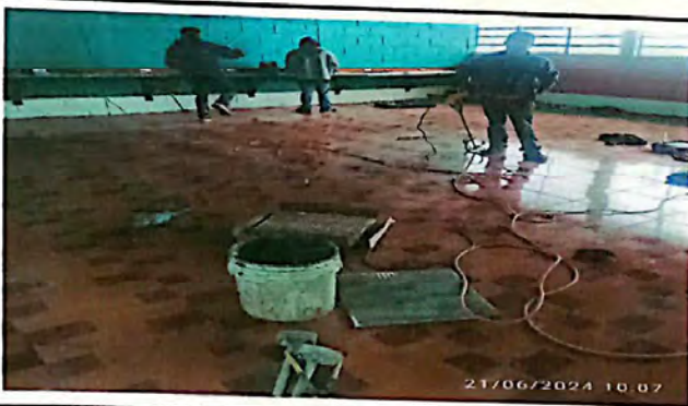
Foto 5: Sustitucion de Piso
