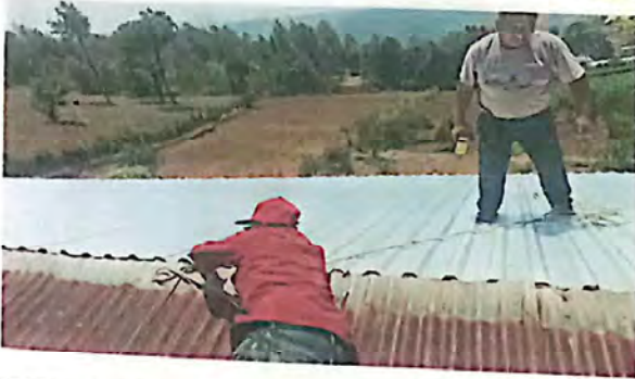
Foto1: Cambio de techo
