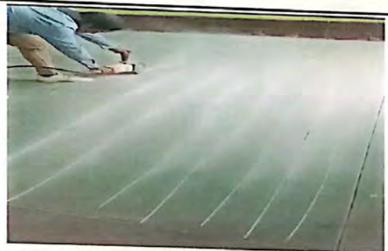
Foto 6: Sustitucion de piso
