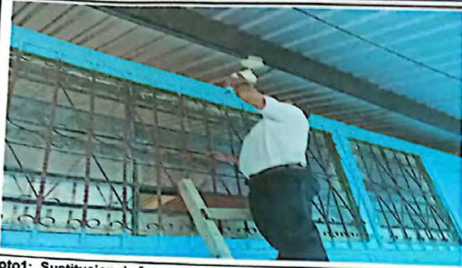
Foto1: Sustitucion de focos ahorradores
