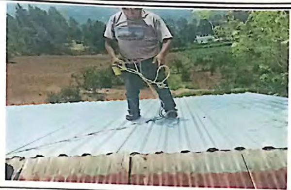
Foto 2: Cambio de Techo
