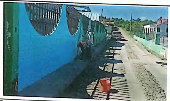
Foto 4: Pintura en muros exteriores
