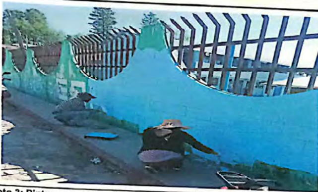
Foto 3: Pintura en muros exteriores
